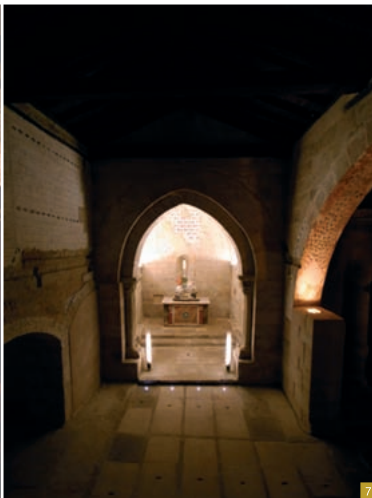
4. Interior de la iglesia rupestre de Olleros de Pisuegra (Palencia), una vez concluidas las obras de restauración.
