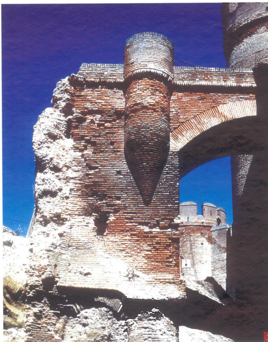
1. Entrada al interior del Castillo de Calatrava la Nueva (Ciudad Real)
